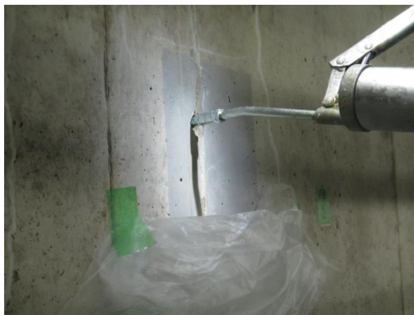
(写真-8) 注入状況
