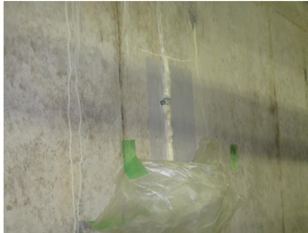
(写真-9) 注入完了
