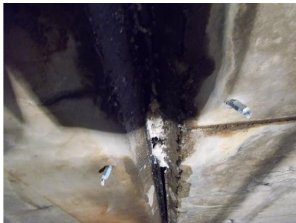
(写真-4) 注入プラグの設置状況
