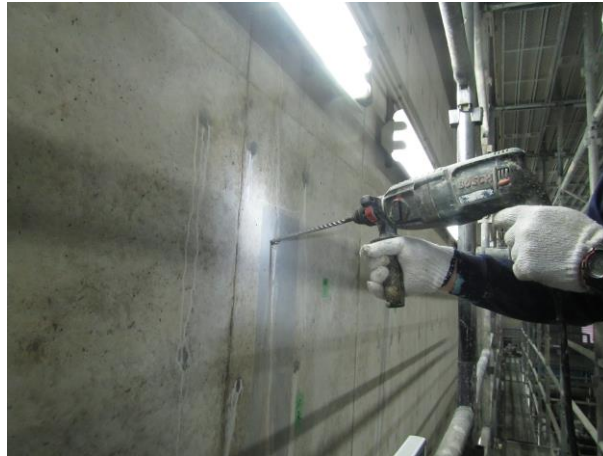
(写真-3) 削孔状況
