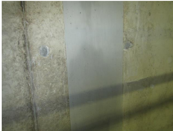
(写真-10) 注入孔の補修状況
